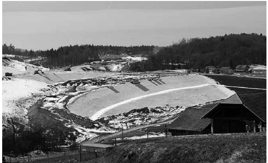
Gradbišče AC odseka in priključne ceste v Dolenji vasi
